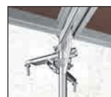
Zwei Gerüsthalter , die V-förmig mit je einer Normalkupplung am Innenstiel angeschlossen werden.
